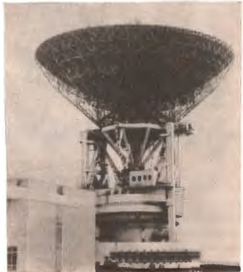
Советский радиотелескоп (РТ-70) с неповоротной квазипараболической антенной (диаметр зеркала 70 м), обеспечивающий связь с космическими аппаратами в пределах Солнечной системы (Центр дальней космической связи, г. Евпатория).
